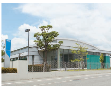
Exterior of YKK Rokko Corporation
