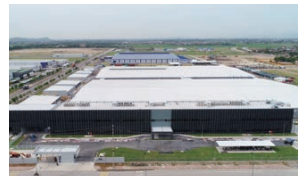
运用了最新系统的新工厂
