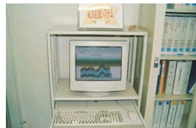
電力監視システム
