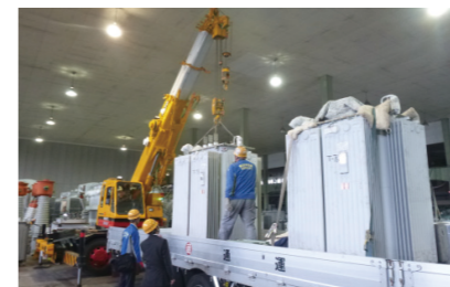
黒部事業所微量PCB含有機器搬出作業の様子
