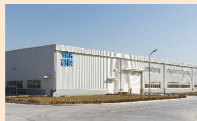
「門窓工場」外観
